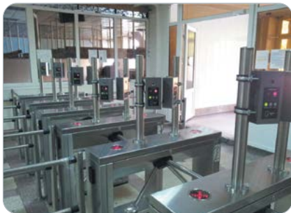
Telepítés beléptető rendszerrel Oroszországban
